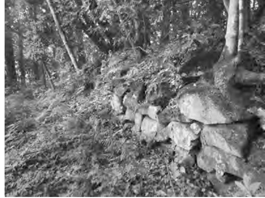
写真 39 本丸主郭 I 石積み (南から)
