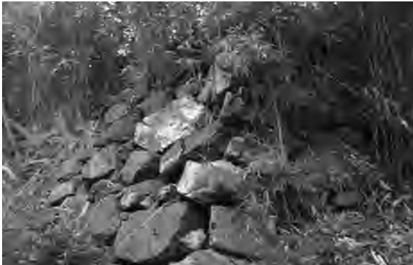
写真 202 曲輪 I 南西石垣の隅角部 (南西から)
